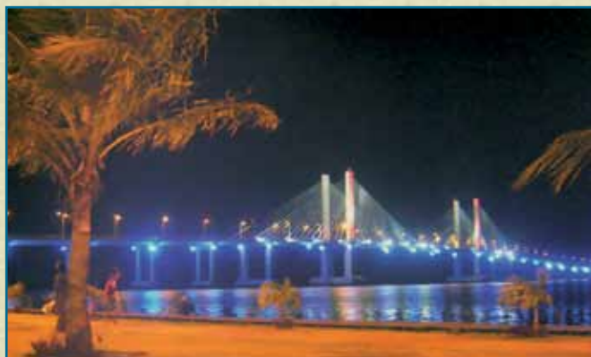
Ponte Aracaju-Barra dos Coqueiros
