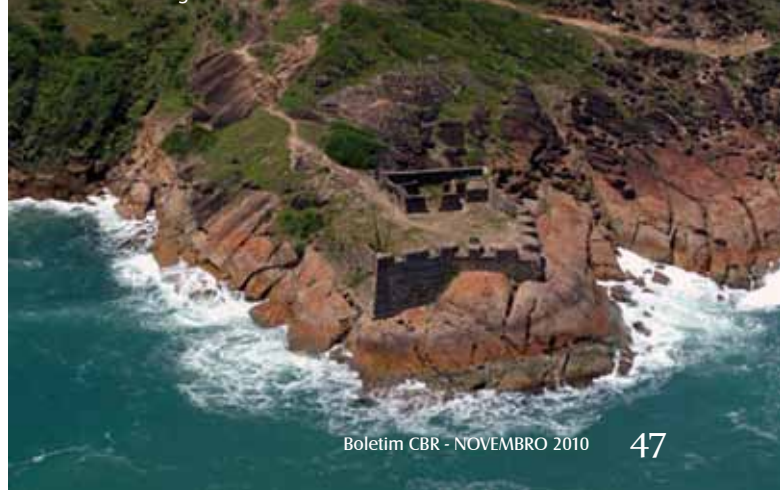
Cabo de Santo Agostinho - Forte Castelo do Mar
