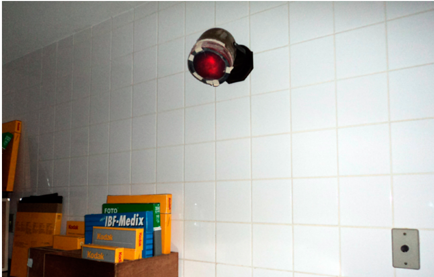
Figura 84. Canhão da luz de segurança da câmara escura Fonte: Acervo SQRI.
